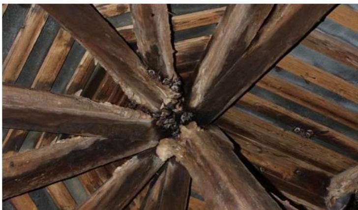
Fot. Nocki duże na strychu kościoła w Krasieczynie. Fot. M. Zegarek.
