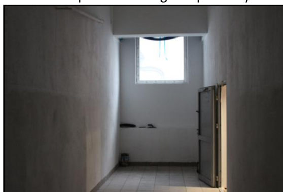
Fot. Pomieszczenie warsztatowe.
