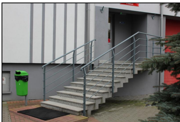
Fot. Wyremontowane schody.
