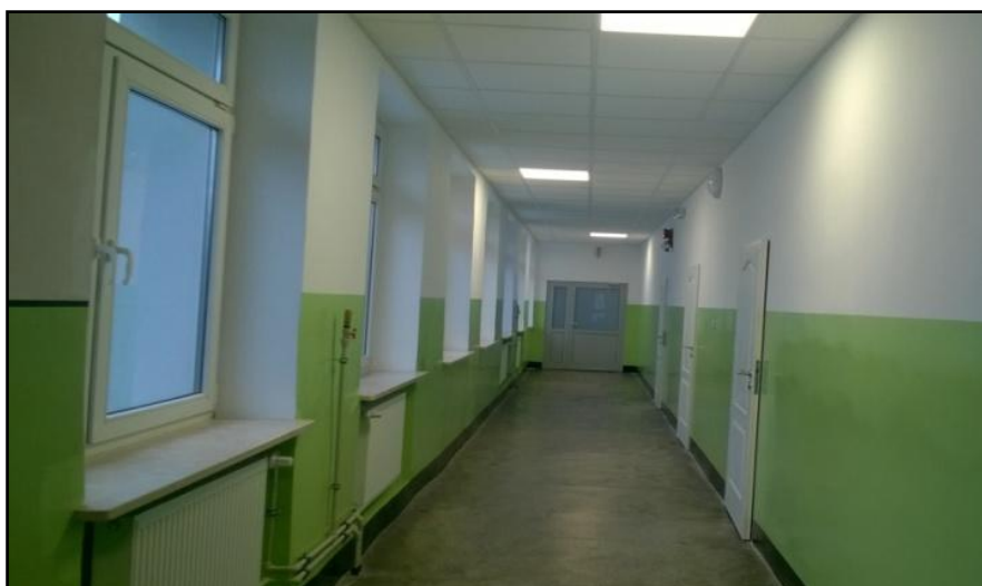
Fot. Remont korytarza.
