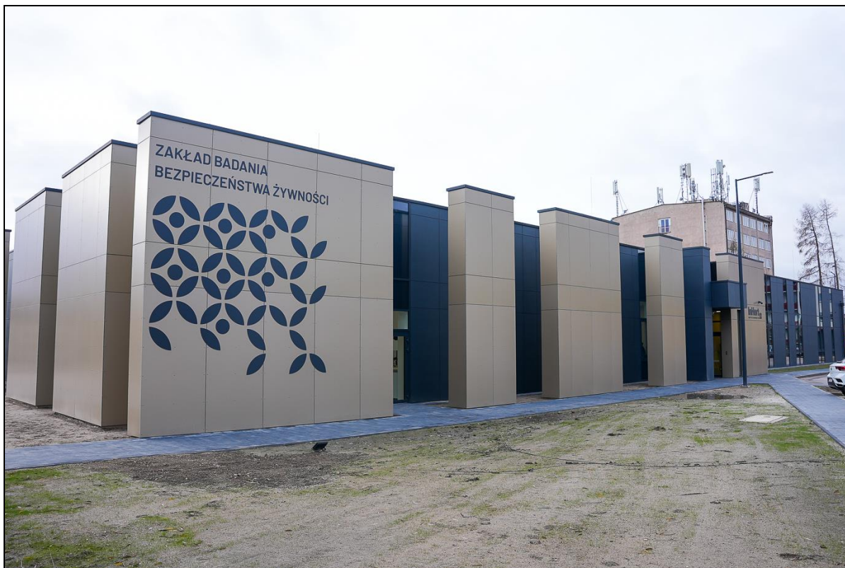
Rysunek 5 Budynek Laboratorium Zakładu Bezpieczeństwa Żywności, Skierniewice Źródło: https://www.gov.pl/photo/f306eda8-ffad-48e2-989a-76b897d422a6
