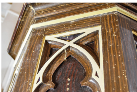
35. Ambona z kościoła pw. św. Wojciecha Biskupa i Męczennika w Uhowie – stan w trakcie prac konserwatorskich – uzupełnianie ubytków drewna i zaprawy.
