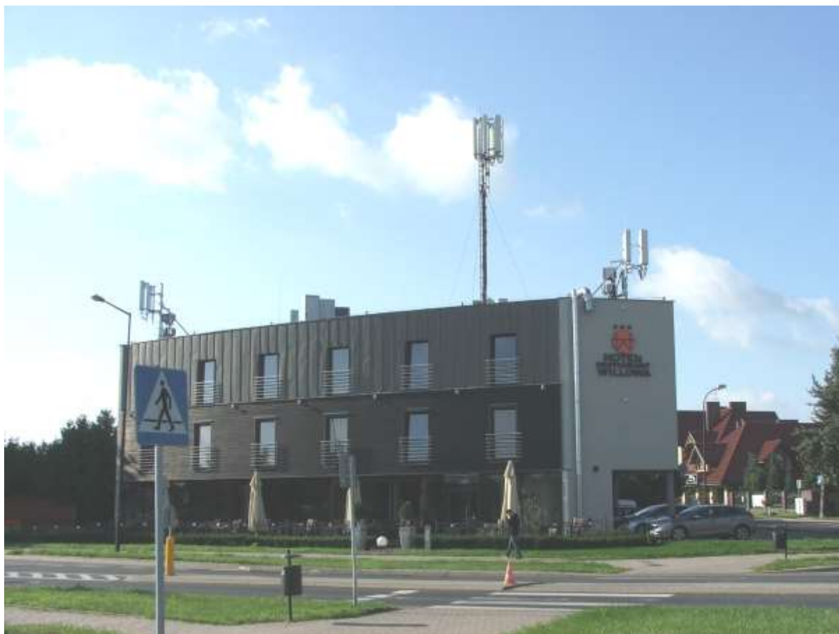
Fot. 1: Widok anten stacji bazowych: ID: LUB1067_F ID: 86273N! (WILLOWA GN_U132) zlokalizowanych przy ul. Sławinkowskiej 15a, Lublin
