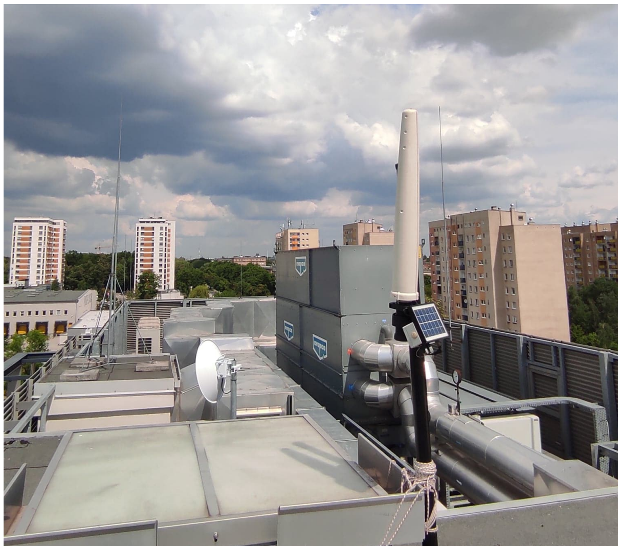
Rys. 3 Miejsce montażu SMS PEM – WCWJ w Poznaniu – widok na SBTK
