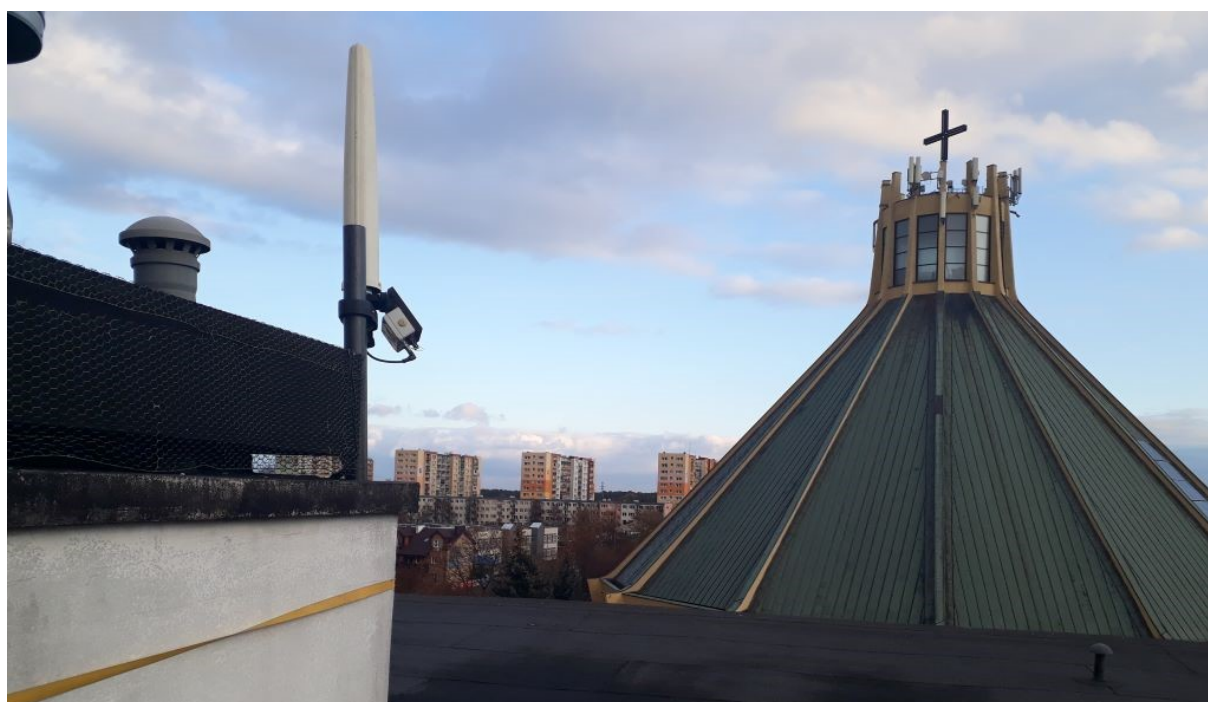
Rys. 4 Miejsce montażu SMS PEM – Ostrowska 6, Włocławek – widok na SBTk
