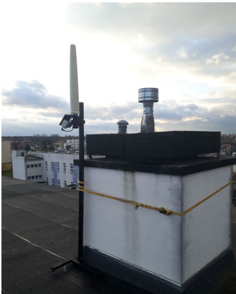
Rys. 3 Miejsce montażu SMS PEM – Ostrowska 6, Włocławek
