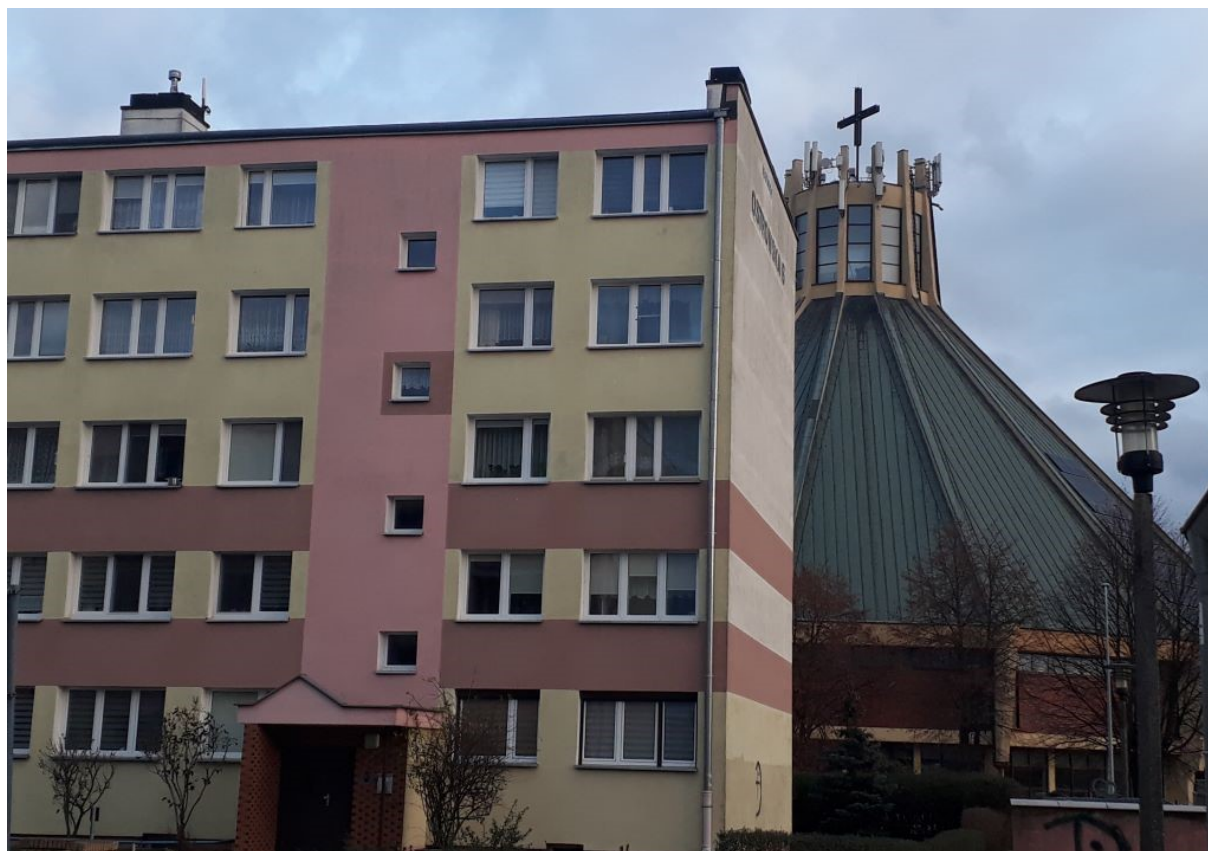
Rys. 2 Miejsce montażu SMS PEM – Ostrowska 6, Włocławek – widok z poziomu gruntu
