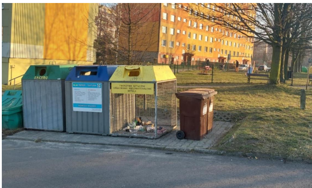
Zdjęcie: Wiata śmietnikowa na jednym z Siemianowickich osiedli mieszkaniowych
