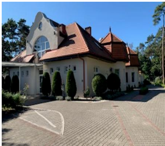
Budynek Hospicjum Fot. Renata Bednarska
