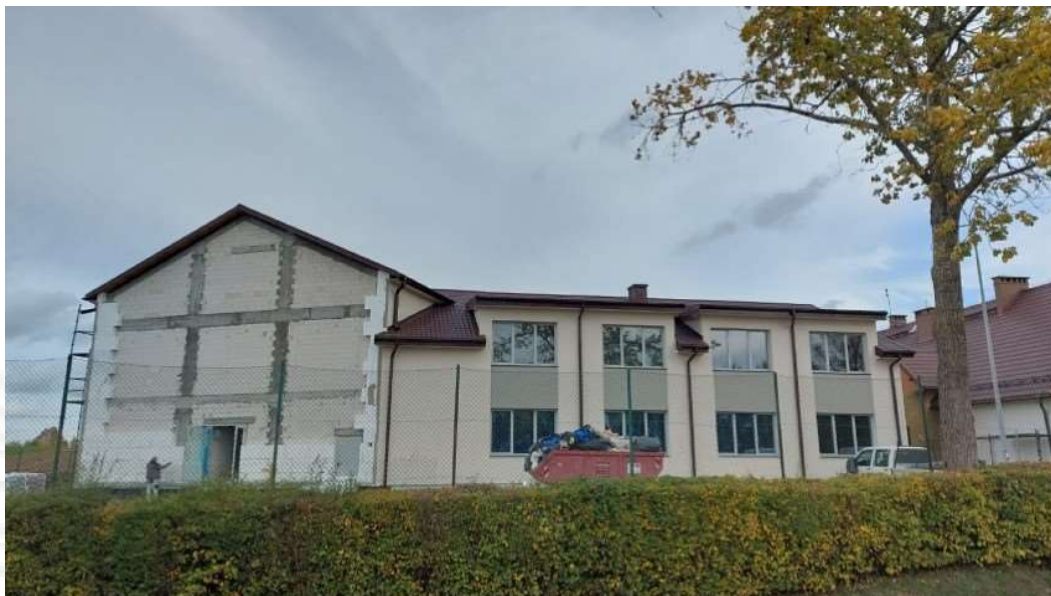
Graf. 12. Budowa hali sportowej w Wilanowie
