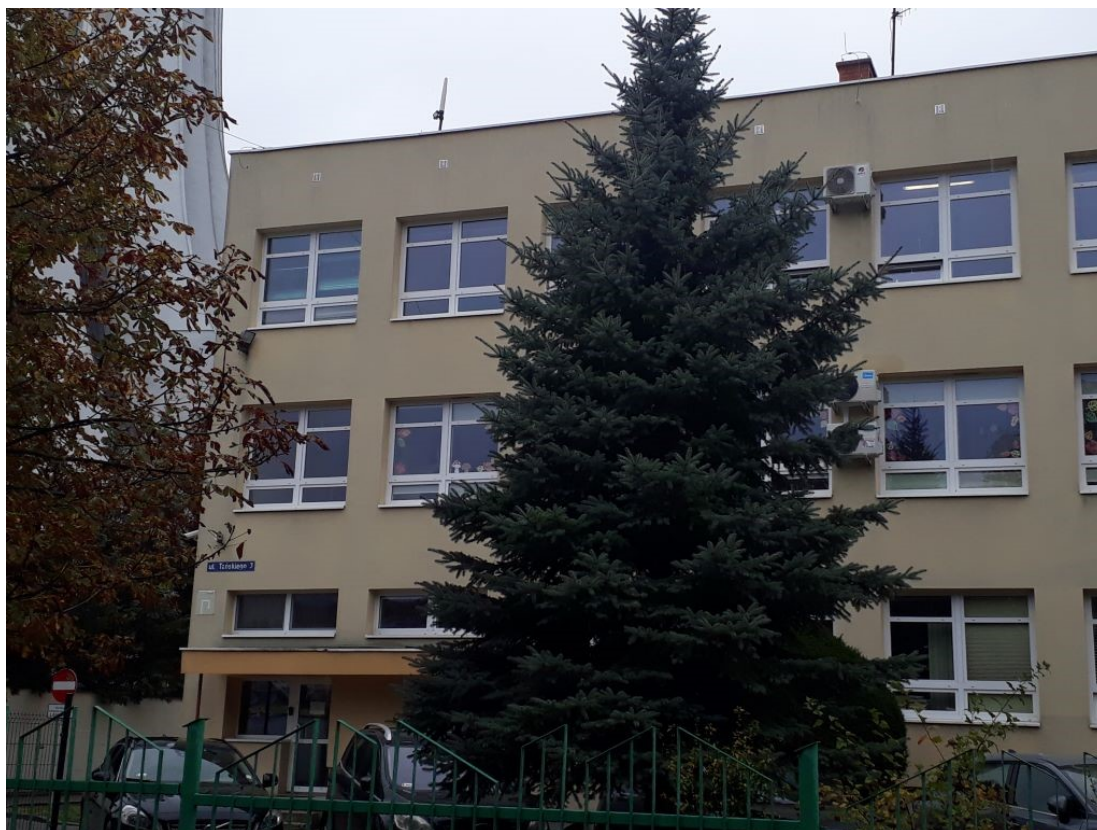
Rys. 2 Miejsce montażu SMS PEM – ZSO nr 1 w Mielcu – widok z poziomu gruntu
