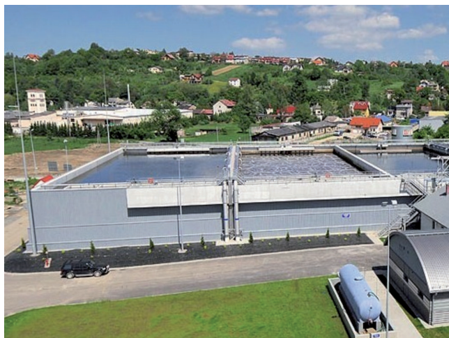
Fot. 7. Reaktory C-Tech Miejskiej Oczyszczalni Ścieków Komunalnych w Żywcu
