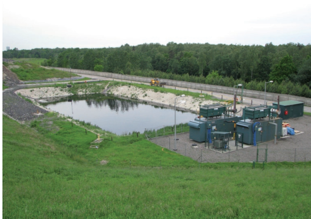
Fot. 1. Zbiornik odcieków i instalacja odzysku biogazu odpadów komunalnych w Knurowie
