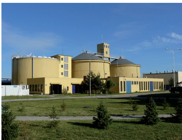
Fot. 9. Oczyszczalnia ścieków w Tychach – Urbanowicach
