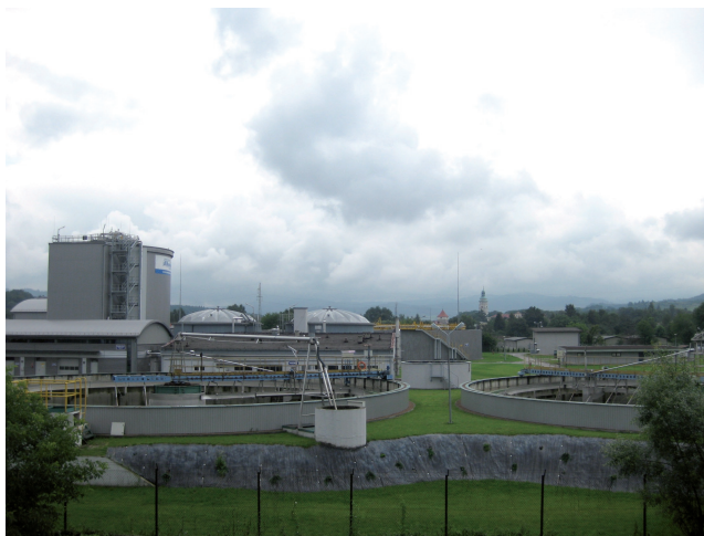
Fot. 8. Miejska Oczyszczalnia Ścieków Komunalnych w Żywcu
