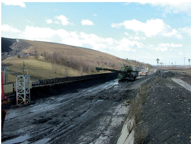
Fot. 5. Obiekt unieszkodliwiania odpadów wydobywczych „Borynia – Jar. Zbiornik 6a”
