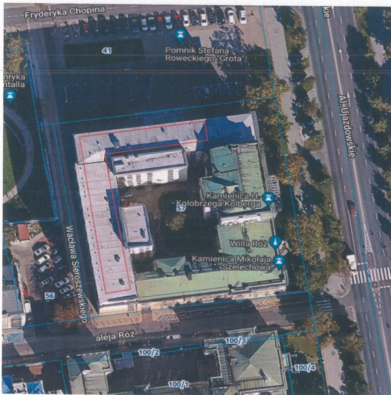
Rysunek 2. Widok dachu obiektu.
