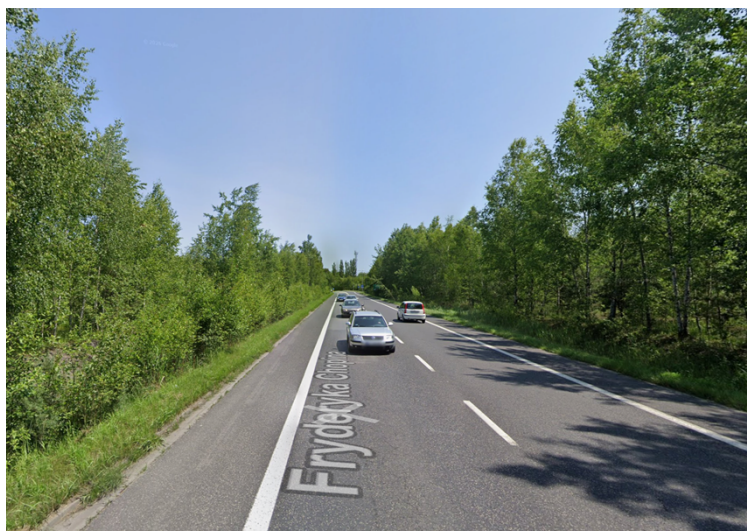
Fot. 2. Jaworzno, Południowa Obwodnica Jaworzna, RB1. Badany odcinek drogi, w kierunku skrzyżowania z ul. Mikołaja Reja.
