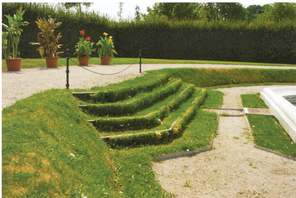
73. Belweder w Wiedniu, ziemne schody zabezpieczone deskami i obłożone murawą.
