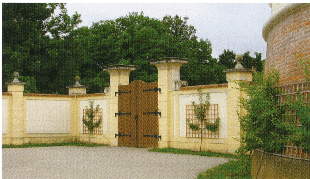
70. Schloss Hof k. Wiednia, mur obsadzony drzewkami. Fot. K. Przylicki, 2010. Schloss Hof near Vienna, wall with trees. Photo: K. Przylicki, 2010.
