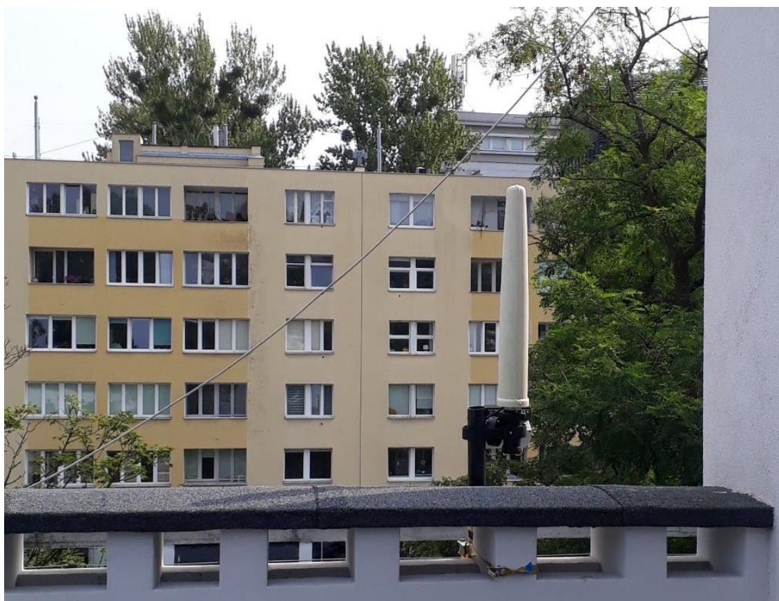
Rys. 2. Miejsce montażu SMS PEM – Zespół Sportowych Szkół Ogólnokształcących
