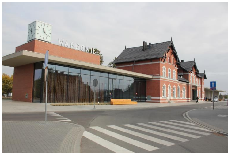
Dworzec kolejowy w Wągrowcu po modernizacji.
