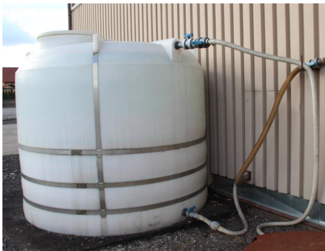
Fot. 1 i 2 Po lewej zbiornik do składowania roztworu chlorku sodu lub wapnia nazywanej powszechnie „solanką”, po prawej – magazyn materiałów do zapobiegania śliskości (chlorek wapnia składowany w workach typu „big bag” oraz dalej po prawej chlorek sodu składowany w stanie luźnym w przyzmach).
