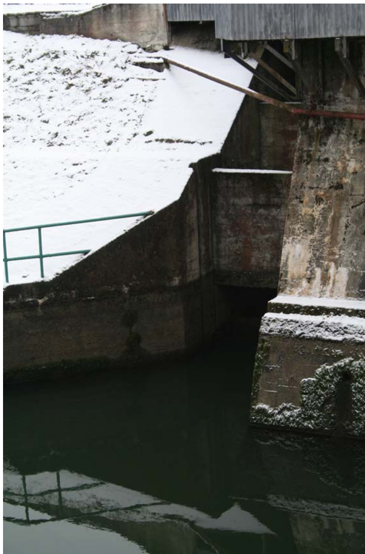
Rys. 5. Wlot do przeławki Rożnów ( Tauroń Ekoservis ) od wody dolnej. GPS 49.761659, 20.663699.
