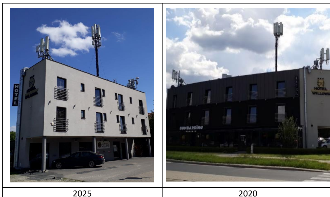
Rys. 16: Widok anten stacji bazowych – ID: LUB1067 oraz ID: 86273
