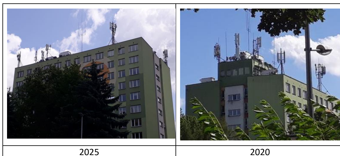
Rys. 22: Widok anten stacji bazowej – ID: LUB1088 oraz ID: 27024
