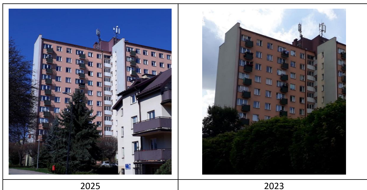
Rys. 12: Widok anten stacji bazowej: – ID: 27003
