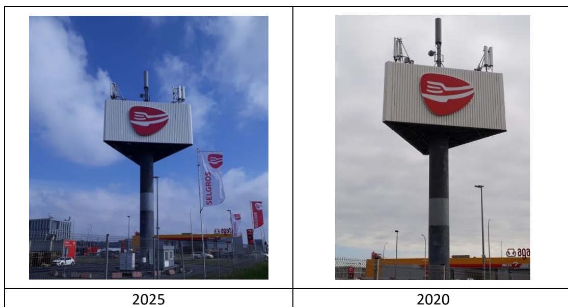
Rys. 20: Widok anten stacji bazowych – ID: LUB1081 oraz ID: BT14527
