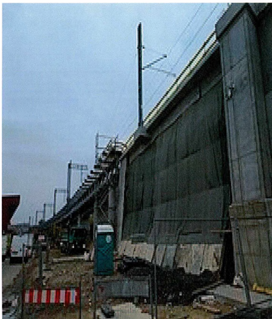
Miejsce budowy przystanku osobowego Krakow Grzegorzki przy ul. Grzegrzeckiej
