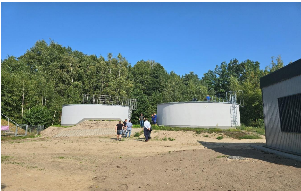
Przebudowa SUW Ostrów (źródło: https://www.celestynow.pl/ )
