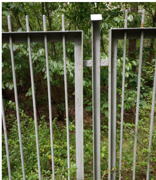
Fot. 3 – Ogrodzenie wieży
