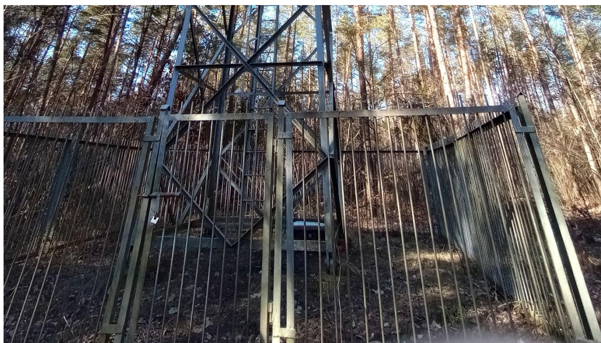
Fot. 2 – Ogrodzenie wieży
