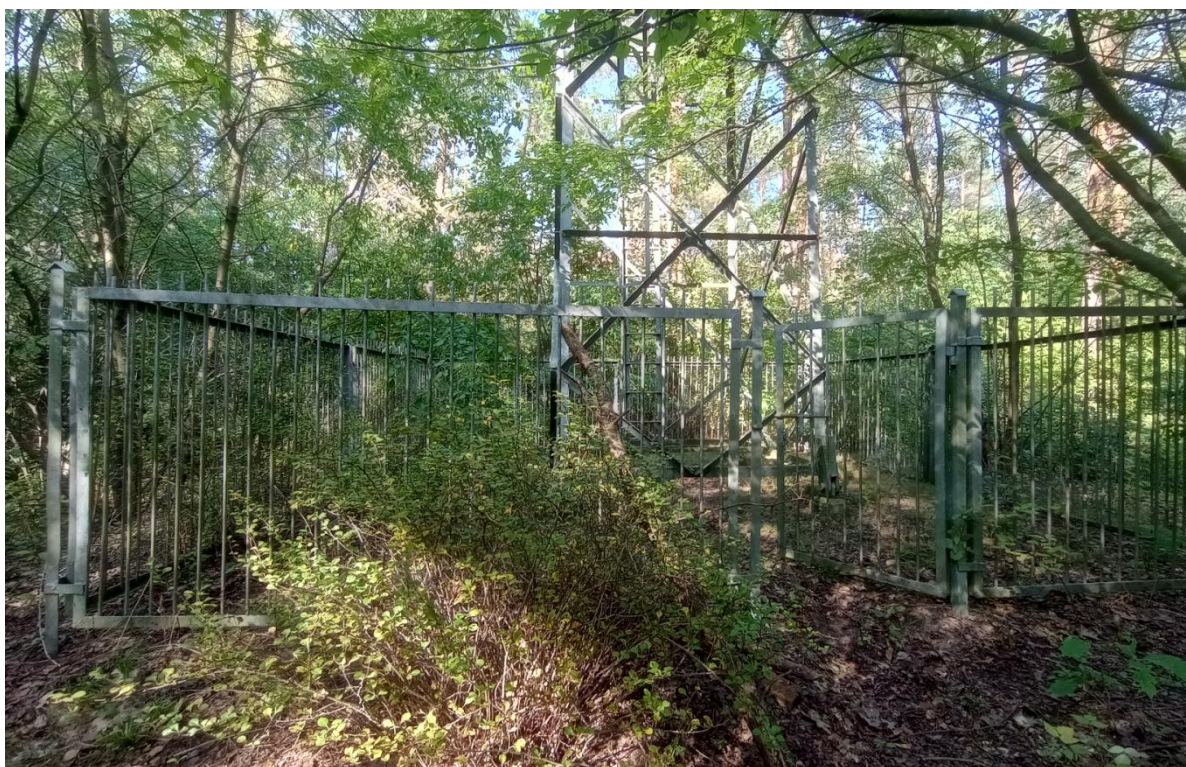
Fot. 1 – Ogrodzenie wieży
