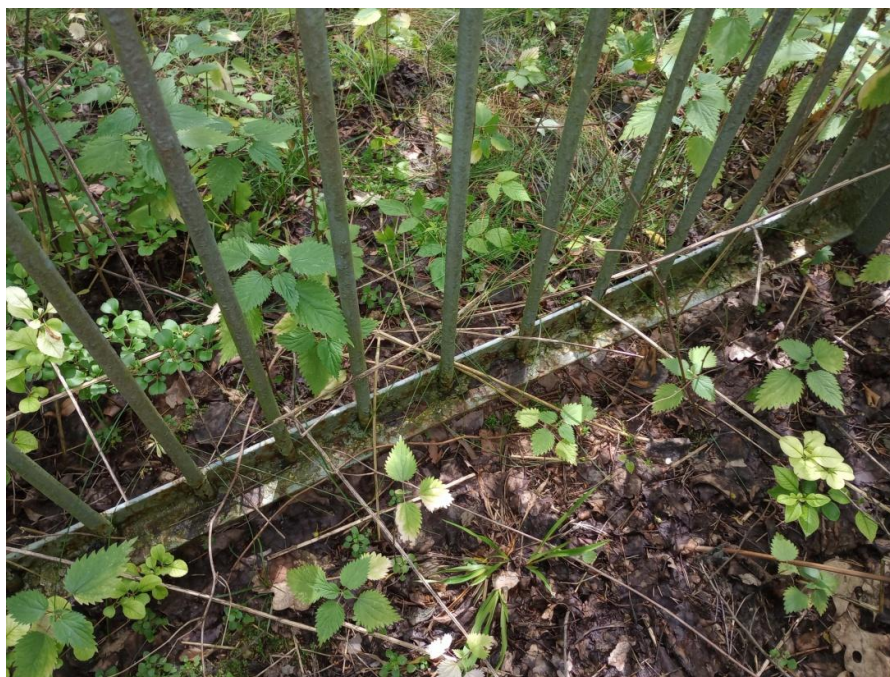
Fot. 5 – Ogrodzenie wieży
