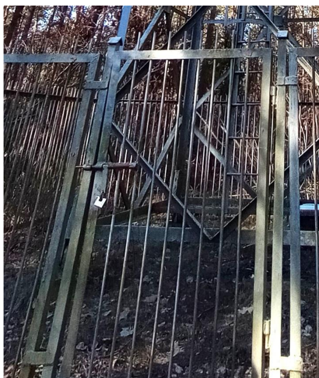
Fot. 6 – Furtka w ogrodzeniu wieży
