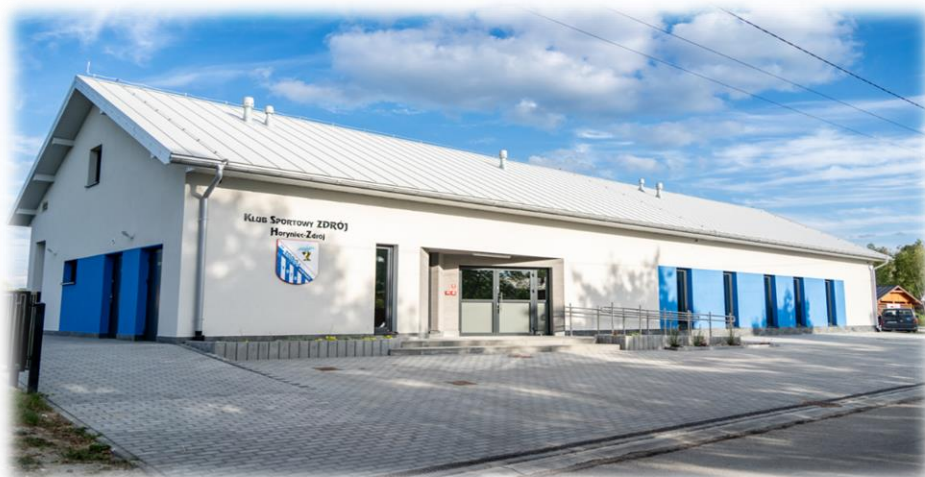
Ryc. 31 Budynek szatniowo – sanitarny Horyniec-Zdrój
