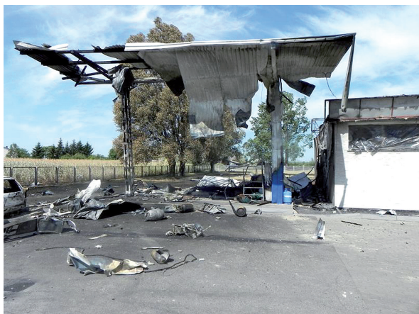
◆ 18, Stacja paliw w Sokołowie Podlaskim po wybuchu gazu; 2015 rok.
