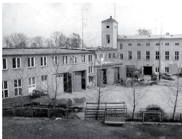
♦ 1. Siedziba Komendy Powiatowej Straży Pożarnych w Sokółowie Podlaskim po rozbudowie; lata 70.
