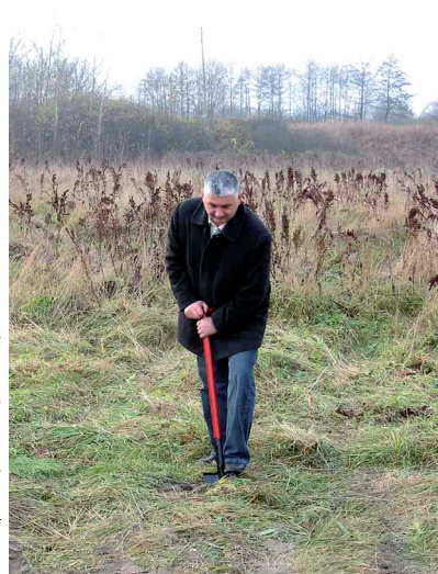
♦ 12. Pierwszy szpadel na terenie budowy nowej strażnicy wbija zastępca komendanta powiatowego PSP w Sokołowie Podlaskim bryg. Roman Malinowski; 8 listopada 2005 roku.
