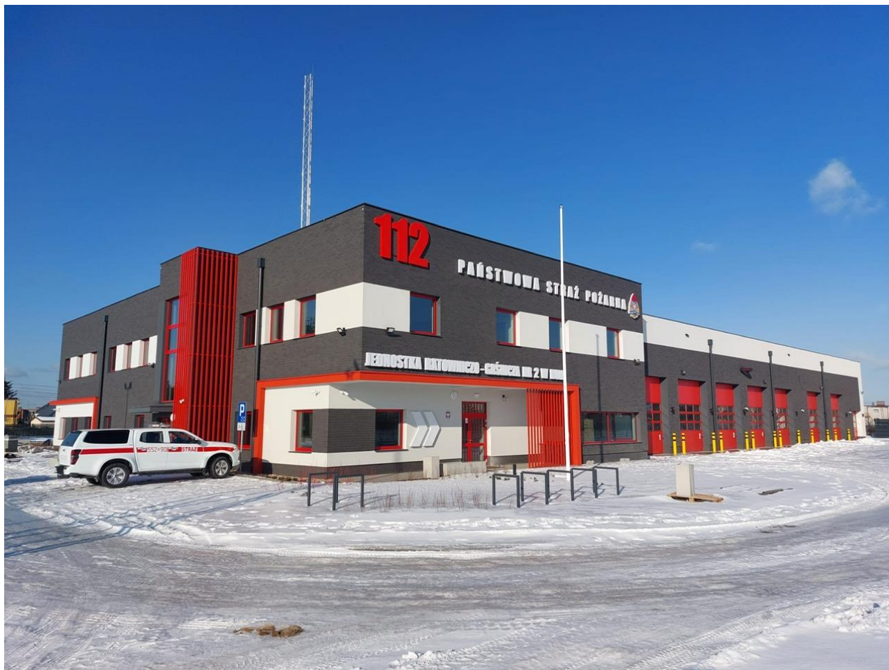
Zdjęcia z realizacji inwestycji
