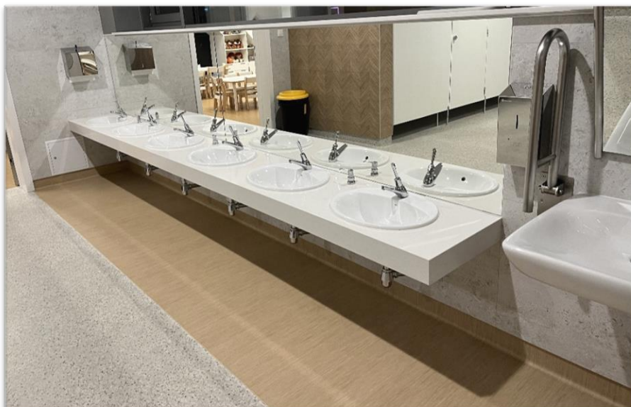
Fot. Nr 7. Pomieszczenie sanitarne w Publicznym Przedszkolu Samorządowym w Baranowie.
