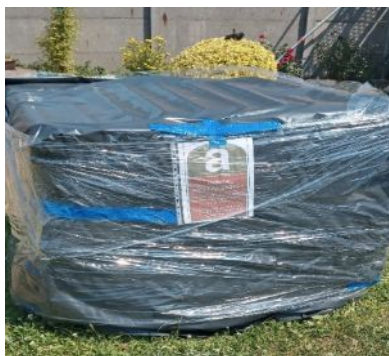
Fot. 5 Zdjęcie przedstawia zabezpieczoną i oznakowaną paletę z płytami azbestowo-cementowymi
