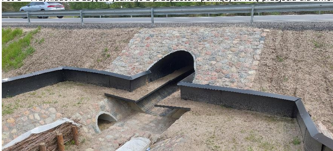
Fot 1 - Przykładowe zdjęcie jednego z przepustów pełniących rolę przejścia dla zwierząt.
