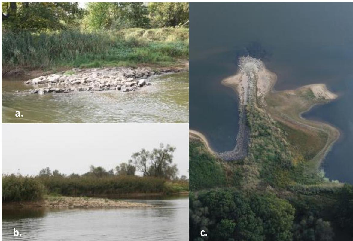
**Abbildung 2:** Buhnen an der Grenzoder a.) Defekte Buhne (615-09); b.) Intakte Buhne (610-15) und c.) Luftbild einer intakten Buhne bei Ratzdorf (Fotos: WSA Oder-Havel).
