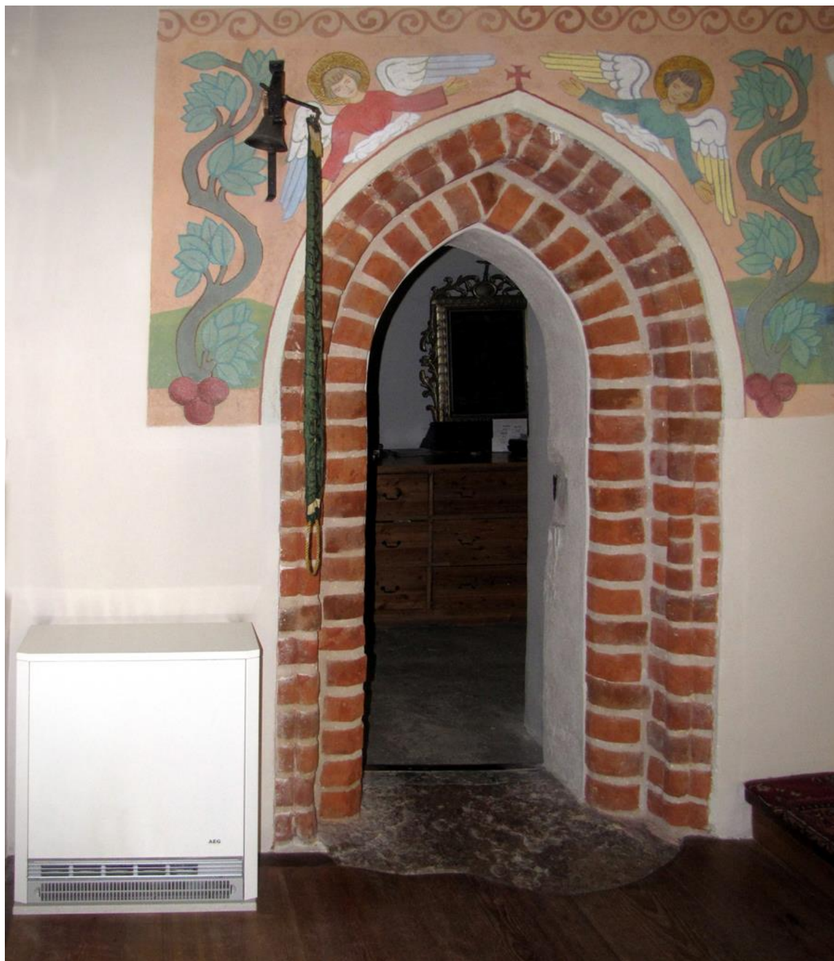
Fot. 11. Niewielkie grzejniki stanowią oczywiście ingerencję w estetykę wnętrza, ale ten został wpasowany w przestrzeń za ścianą tęczową tak, że jest praktycznie niewidoczny dla wiernych znajdujących się w nawie. Montaż tego typu grzejników jest stosunkowo małoinwazyjny. Fot. ks. W. Dokurno
