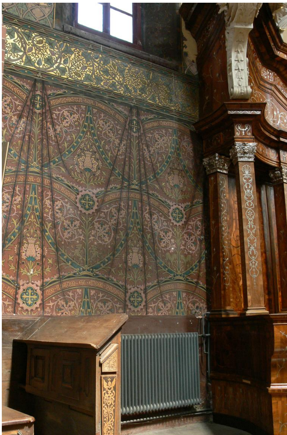
Fot. 1. Nie powinno się wprowadzać instalacji wymagających ingerencji w substancję kościoła - kucia, niszczenia ścian, tynków, posadzek. Tu rozwiązanie z lat 70., którym stworzono zagrożenie dla cennych intarsjowanych ołtarzy i równie cennych malowideł. Fot. B. J. Rouba
