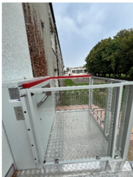
Zdjęcie nr 7 Samorządowy Żłobek „Kiernozik” w Kiernozi – schody zewnętrzne z podnośnikiem pionowym
