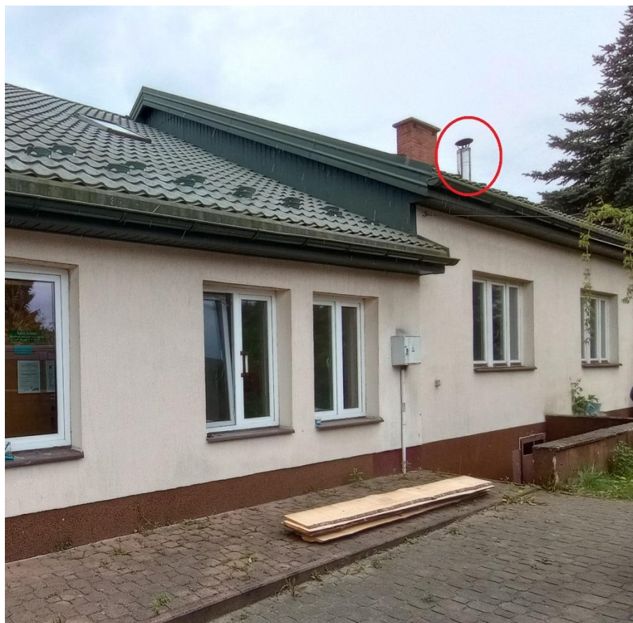
Fot. 4 Istniejący komin zewnętrzny
