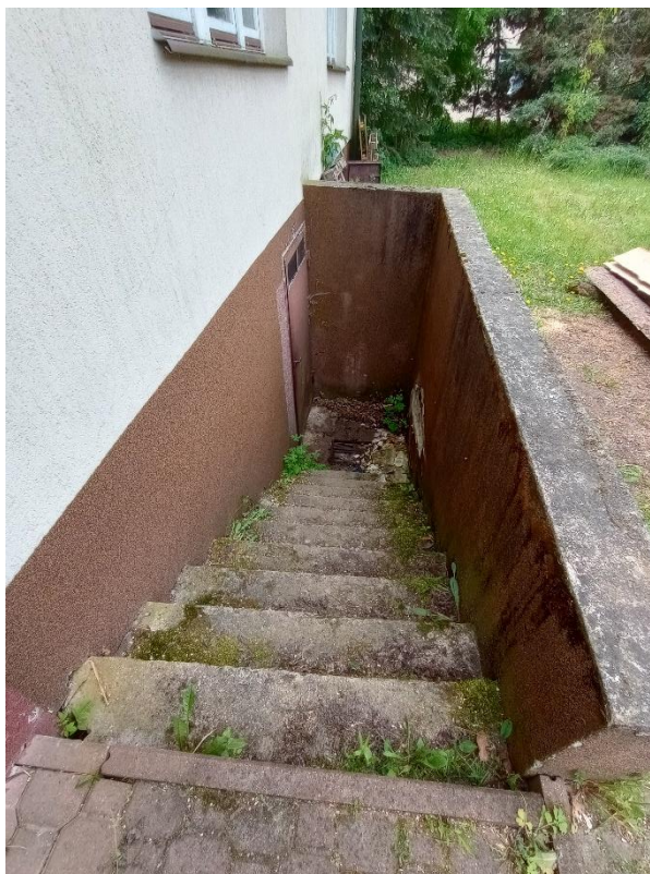
Fot. 1 Schody do kotłowni zlokalizowanej w piwnicy
