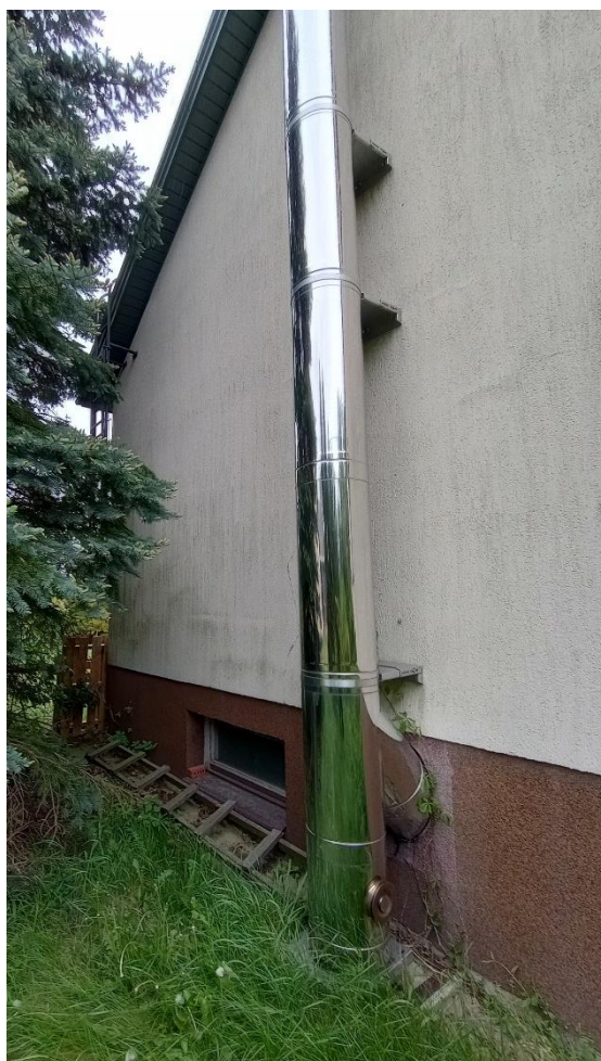
Fot. 5 Istniejący komin zewnętrzny
