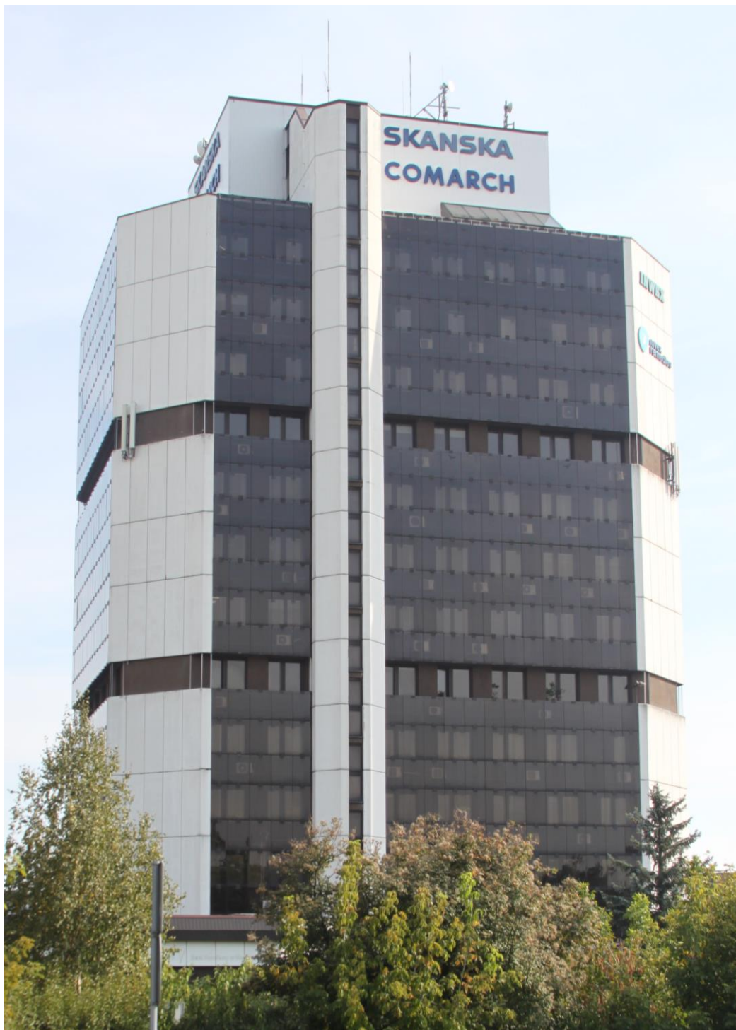
Fot. 1: Widok anten stacji bazowej ID: 10220, zlokalizowanej przy al. Solidarności 34 w Kielcach
