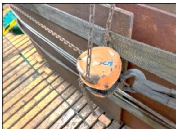
Wykres 4: Zabezpieczenie płyt za pomocą bloku łańcucha i nylonowych zawiesi
