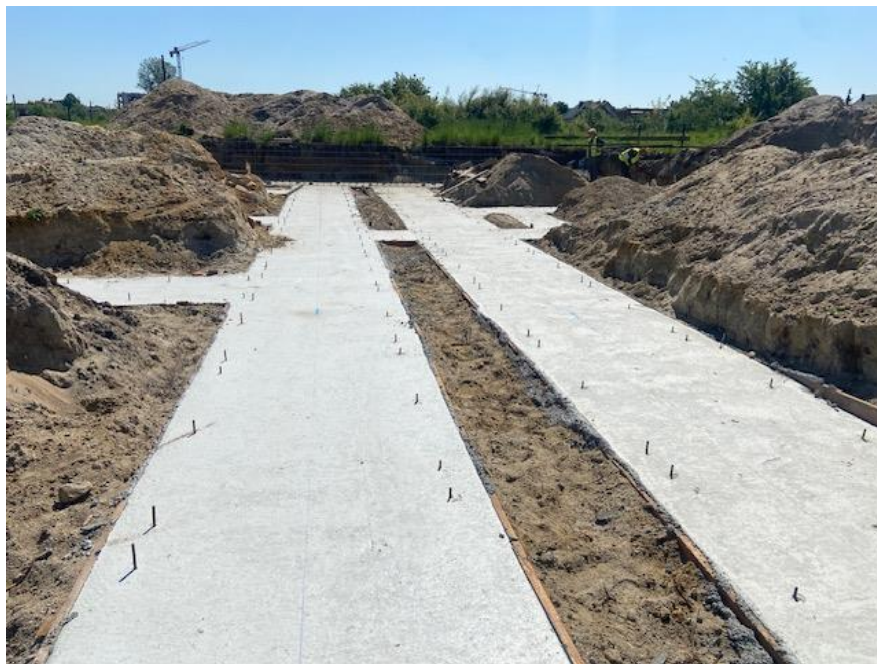
Ławy pod budynek
