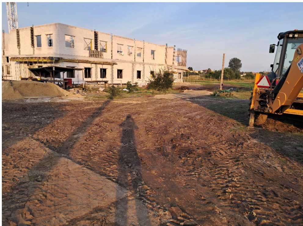
Ściany budynku – pierwsze piętro
