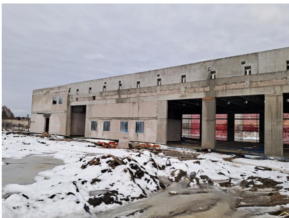
Hala garażowa z pomieszczeniami warsztatowymi
