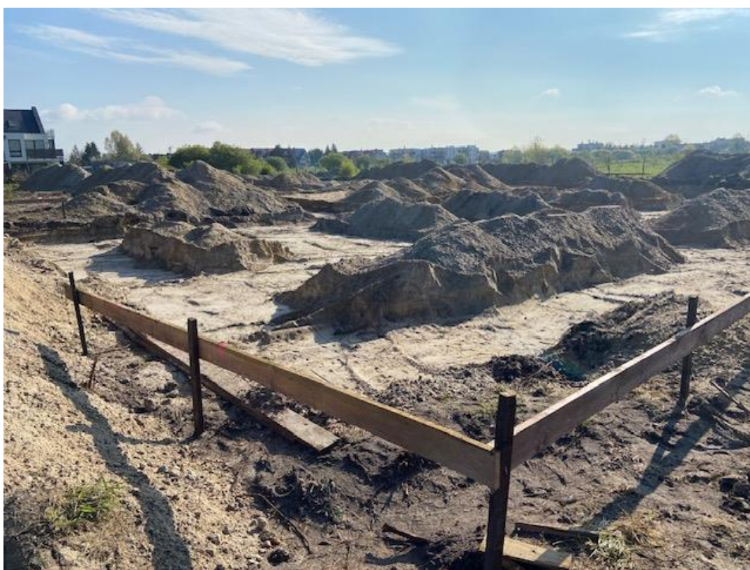
Prace ziemne – przygotowanie terenu pod budowę
