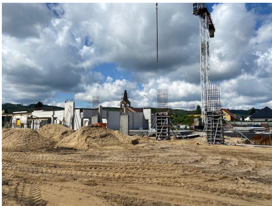
Ściany budynku - parter
