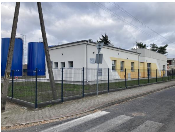
Zdjęcie 3. Stacja Uzdatniania Wody w Zaniemyślu
