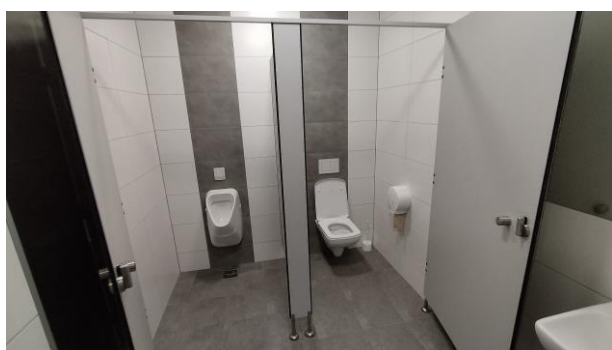
Zdjęcie 7. Sanitariaty przy szatni męskiej
