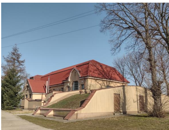
Zdjęcie 1. Stacja Uzdatniania Wody w Środzie Wielkopolskiej
