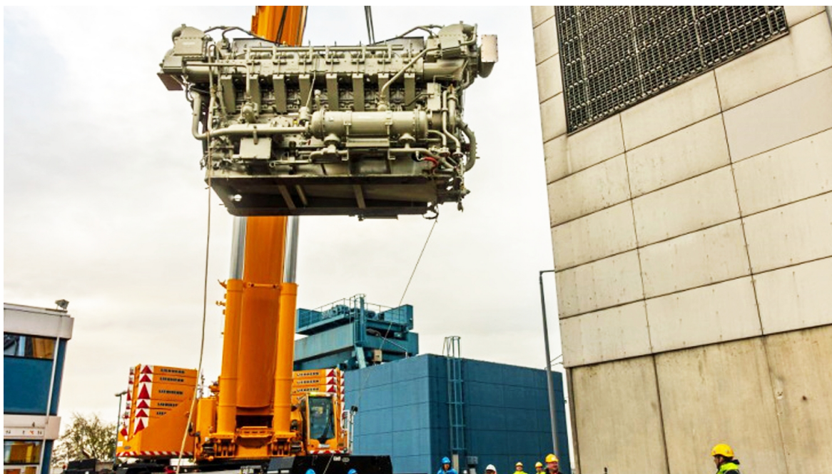
Rys. 9. Dostawa używanego silnika wysokoprężnego do Elektrowni Jądrowej Loviisa w Finlandii. Agregat prądotwórczy został zakupiony z likwidowanej EJ Krümmel w Niemczech (fot. Vattenfall).
