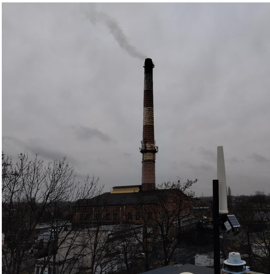
Rys. 3 Widok na SBTk z miejsca montażu SMS PEM – Wyższa Szkoła Medyczna
