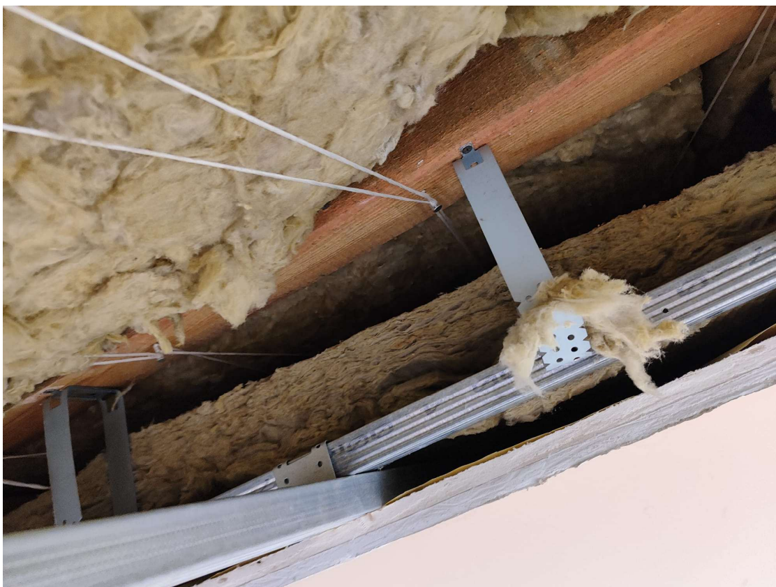
Fot. 19. Stan zabudowy skosów – bez widocznych uszkodzeń
