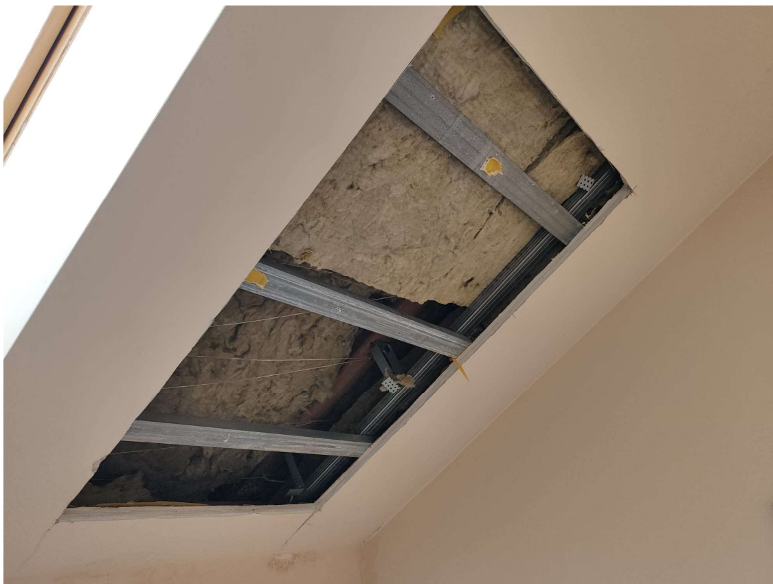
Fot. 15. Miejsce wykonania odkrywki na potrzeby opracowania ekspertyzy
