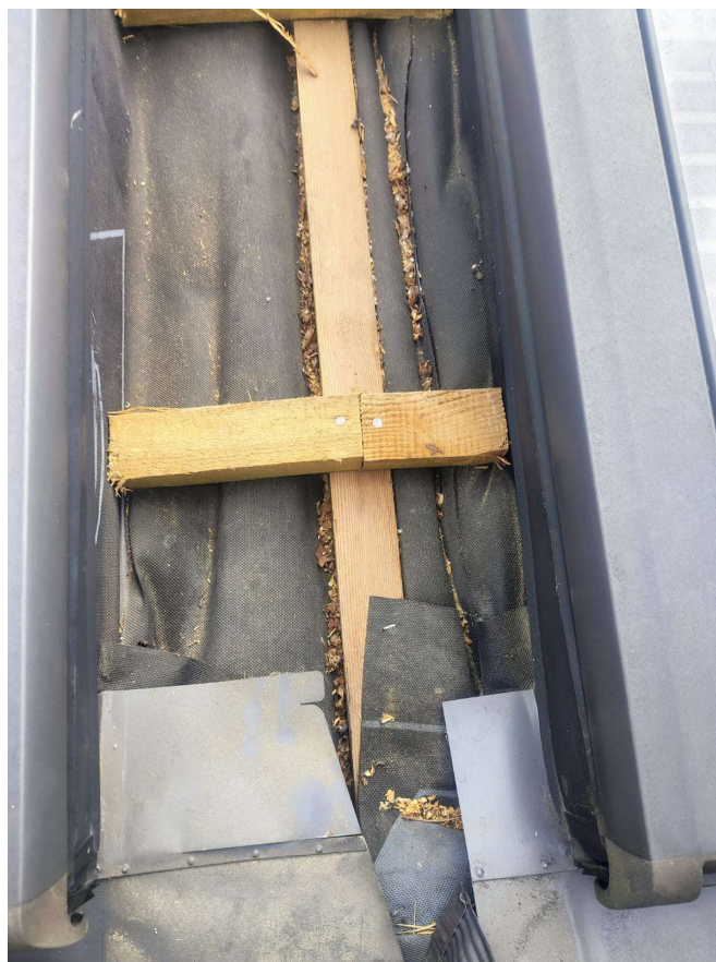
Fot. 13. Brak ciągłości i odpowiedniego ułożenia folii wstępnego krycia
