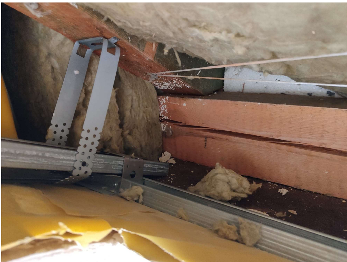
Fot. 17. Stan konstrukcji dachu – brak widocznych uszkodzeń
