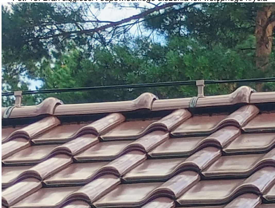
Fot. 14. Wykończenie kalenicy gąsiorami – pod ceramicznym elementem obróbki z taśm wklejanych
