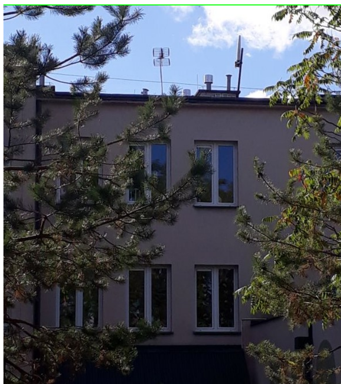
Rys. 2 Miejsce montażu SMS PEM – DPS w Suwałkach – widok z poziomu gruntu
