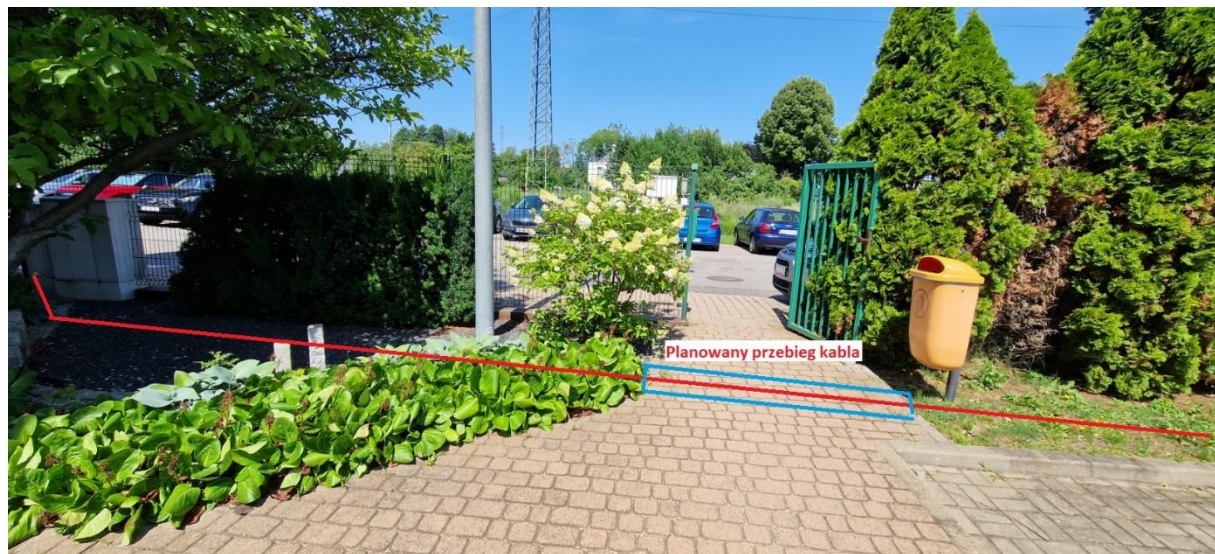
Fot. 2. Trasa kablowa od złącza do furtki w kierunku stacji ładowania
