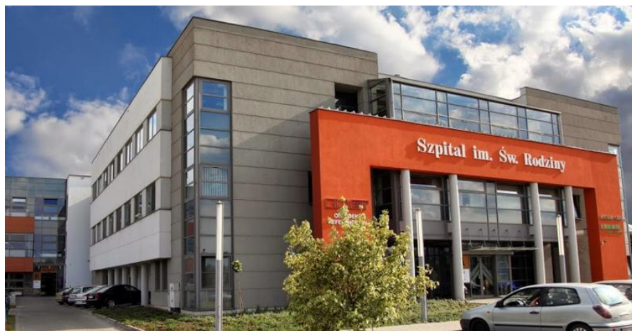
Fot. 1. Szpital Specjalistyczny im. Św. Rodziny w Rudnej Małej k. Rzeszowa.
