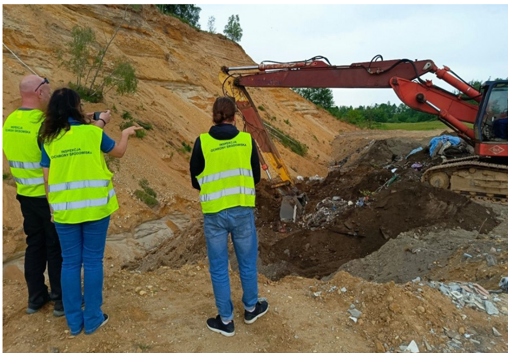
Zdjęcie 1. Rozpoznanie zanieczyszczenia w terenie w związku z ujawnieniem nielegalnego deponowania odpadów na terenie wyrobiska w m. Skrzypiec
