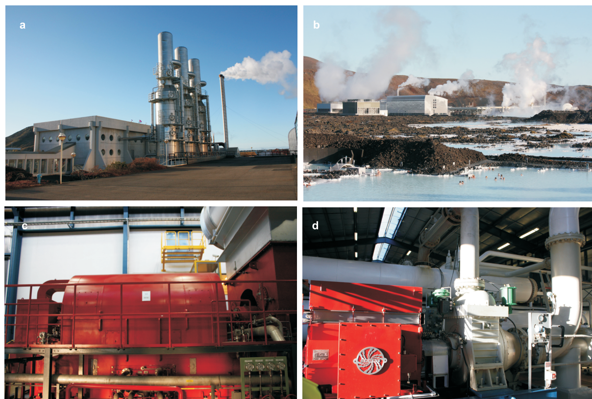
Ryc.3.3.4. Siłownia geotermalna Svartsengi (Islandia) (a) i jej widok na tle kąpieliska „Blue Lagune” (b). Klasyczna turbina na parę geotermalną (c) i obieg ORC (d) (fot. B. Tomaszewska 2012)
