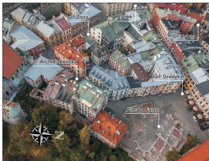
Fot. 1. Fotografia lotnicza północno-wschodniej część Wzgórza Staromiejskiego w Lublinie (fot. P. Pakuła)
