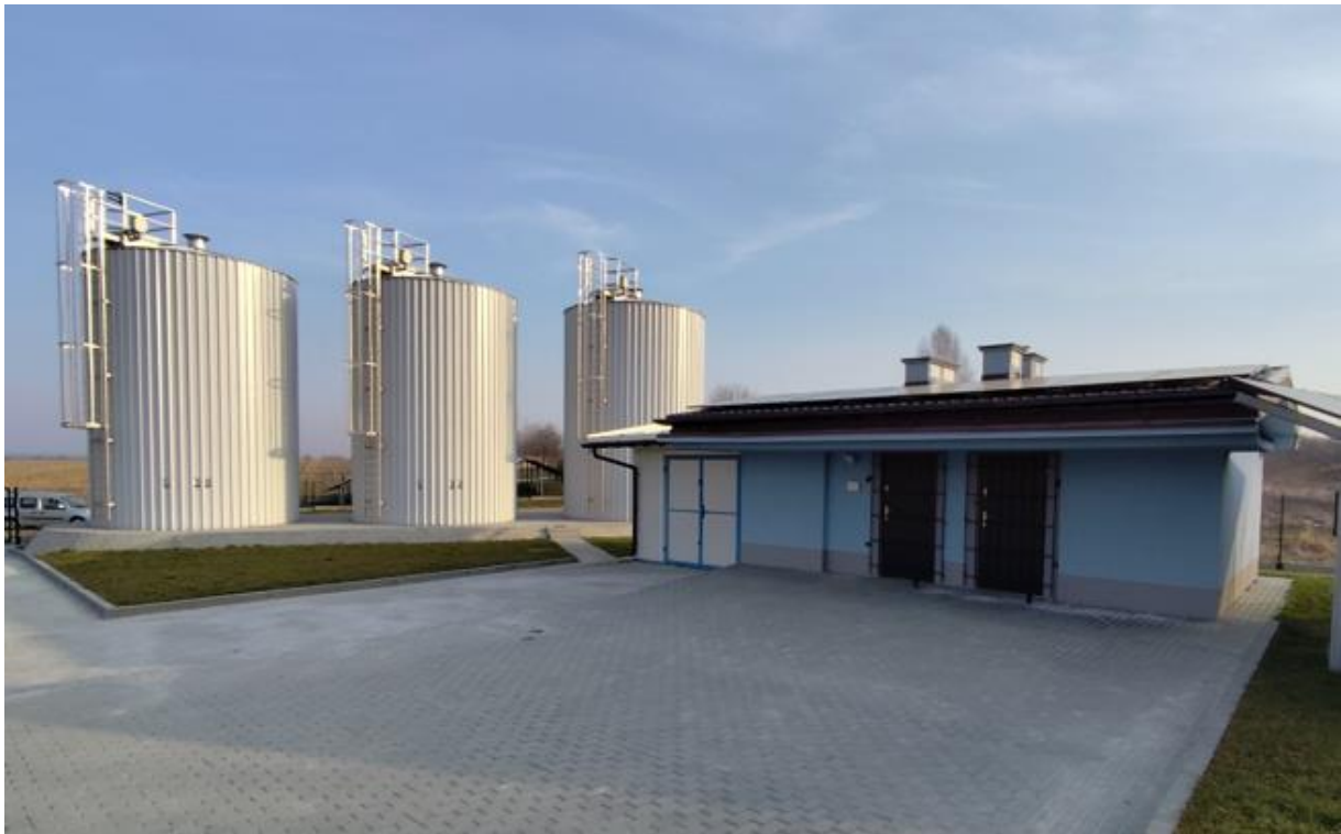
Fot. Stacja Uzdatniania Wody w Świltzy
