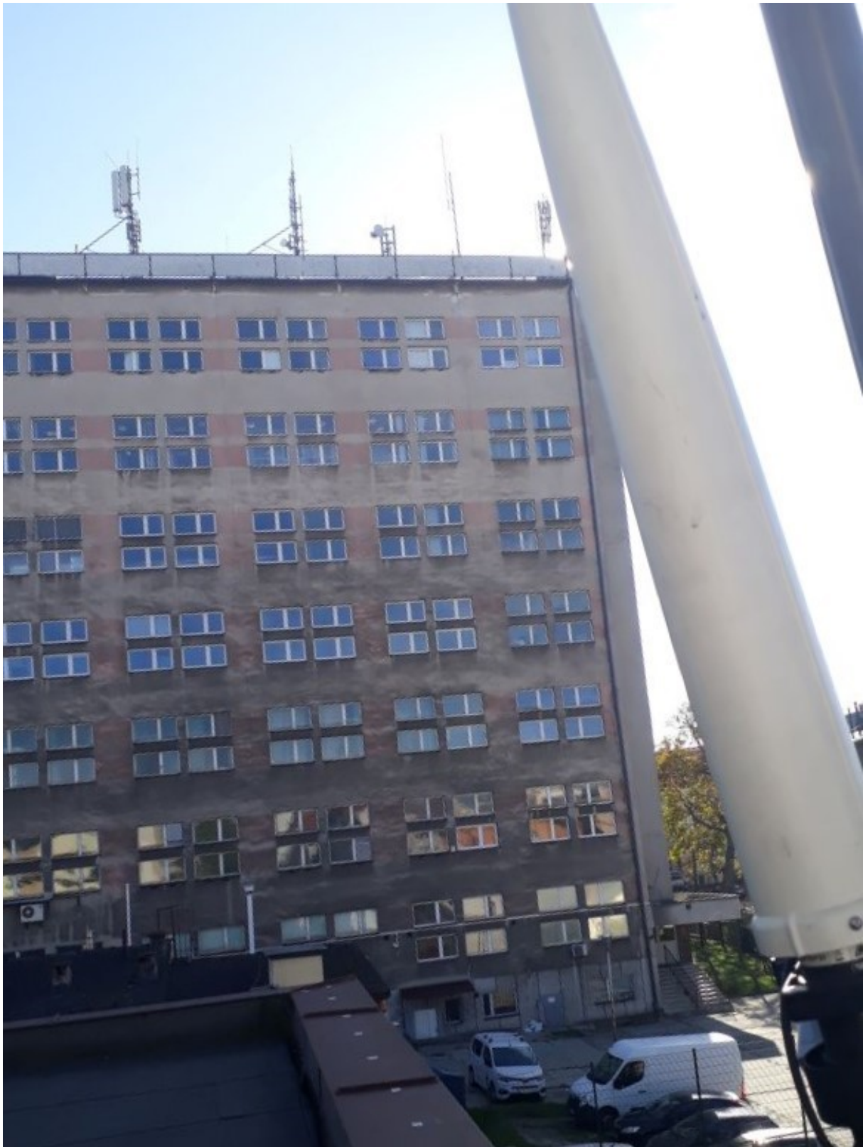
Rys. 3 Miejsce montażu SMS PEM – 3 LO w Tarnowie – widok na SBTk
