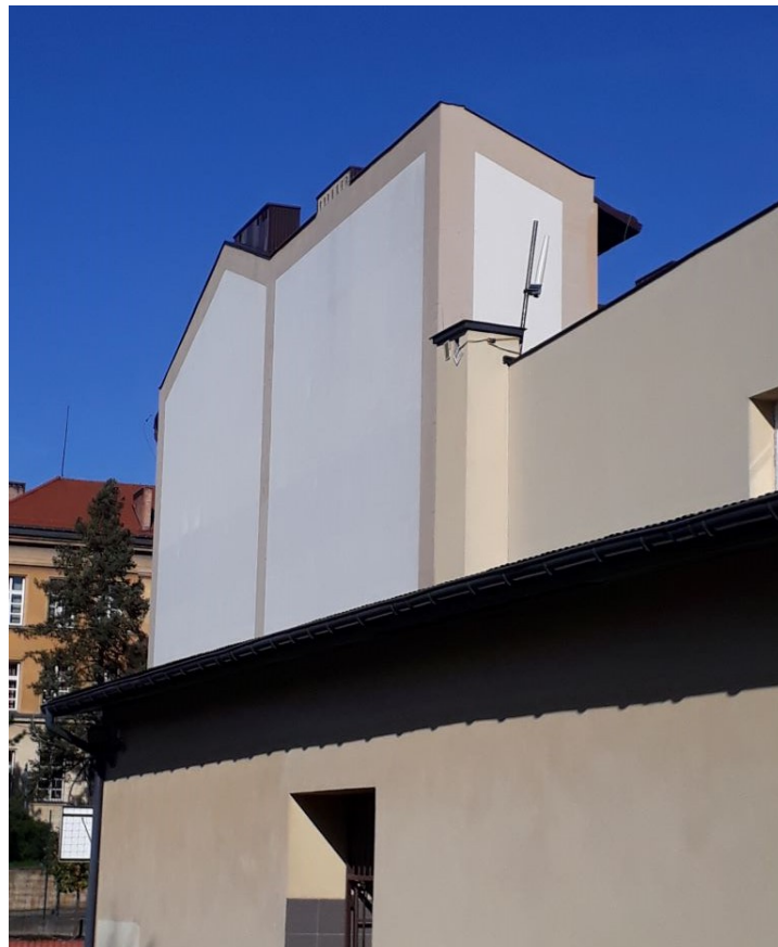
Rys. 2 Miejsce montażu SMS PEM – 3 LO w Tarnowie – widok z poziomu gruntu
