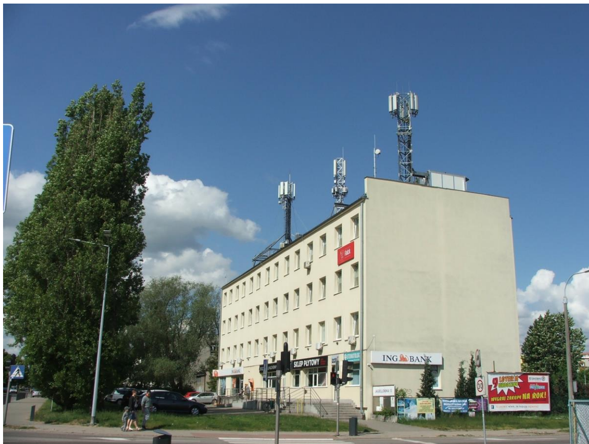
Fot. 1: Widok anten stacji bazowych ID: GDA0008B, ID: BT43288 oraz ID: 4971/5677 (6420)/(40182N), zlokalizowanych przy ul. Jagiellońskiej 13 w Gdańsku
