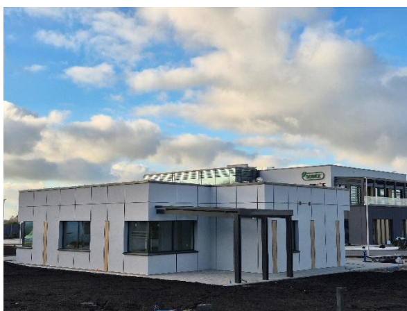
6. Budynek biurowy oraz budynek dozoru w Trzebiczu
